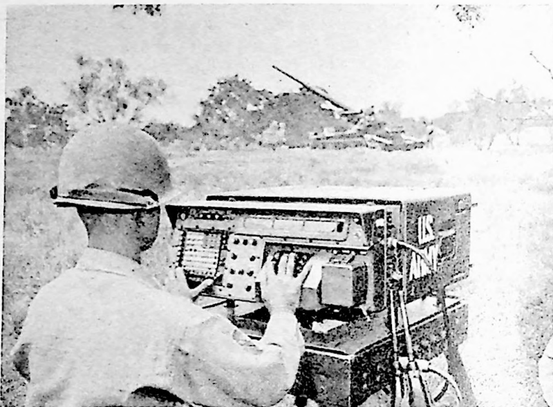
Afb. 12. De Amerikaanse „Field Artillery Digital Automatic Computer”.
