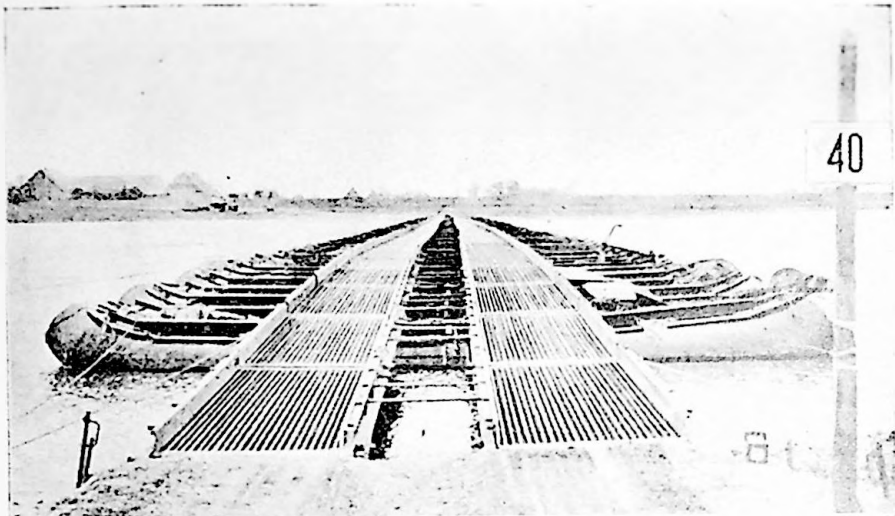
Amerikaanse „Treadway“-brug (Kl 40) over de Elbe te Darchau.
