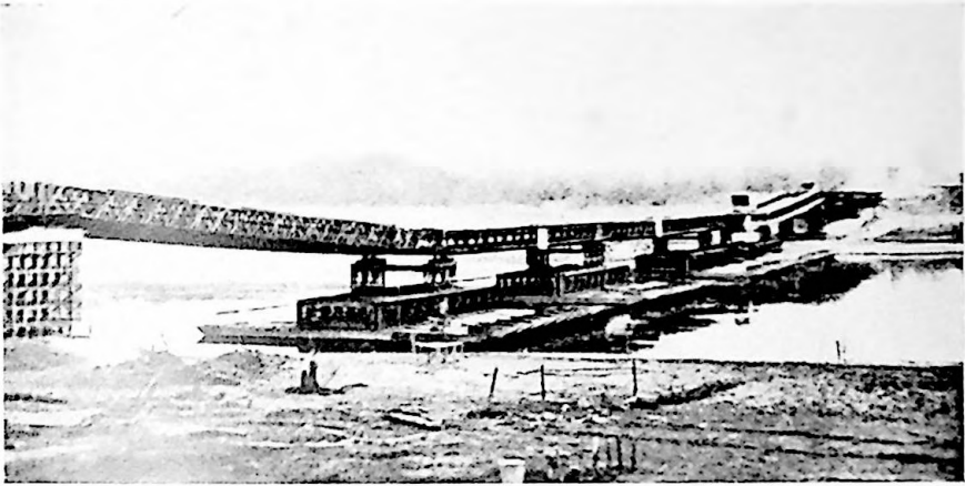
Semi-permanente Bailey-pontonbrug (Kl 40) over de Maas bij Lottum.
