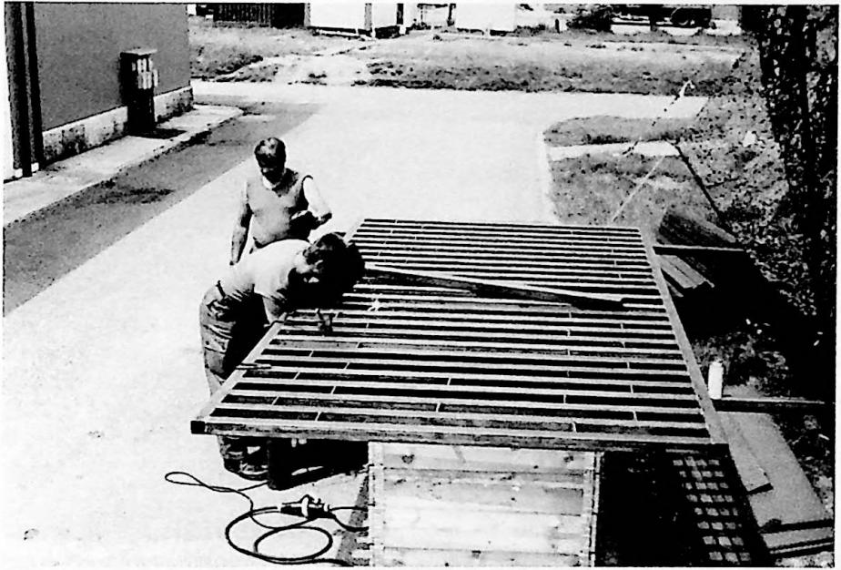
Afb. 1 Roosters worden vervaardigd ter bestrijding van Foreign Object Damage
