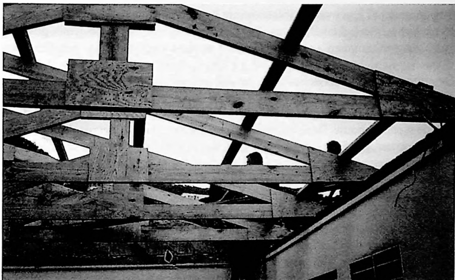
Afb. 8 ...maar dan eerst nieuwe dakspanten aanbrengen (Foto: E.R. Sinninghe)
