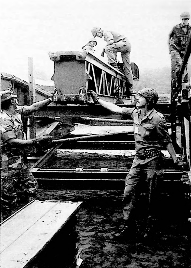
Afb. 2 Het bouwen van een MCB-brug onder Amerikaanse leiding (Foto: 101 Gngcvgp)
