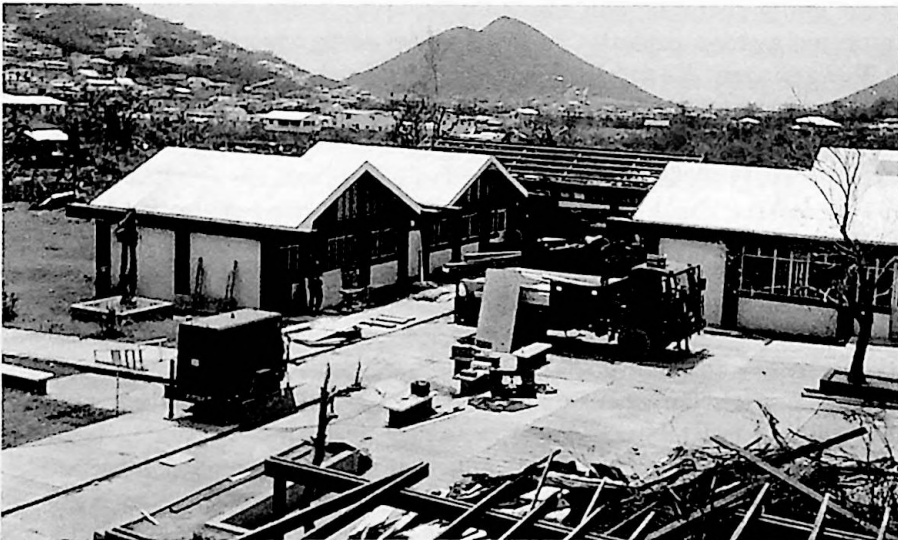
Afb. 7 Nieuwe daken op een school... (Foto: E. R. Sinninghe)
