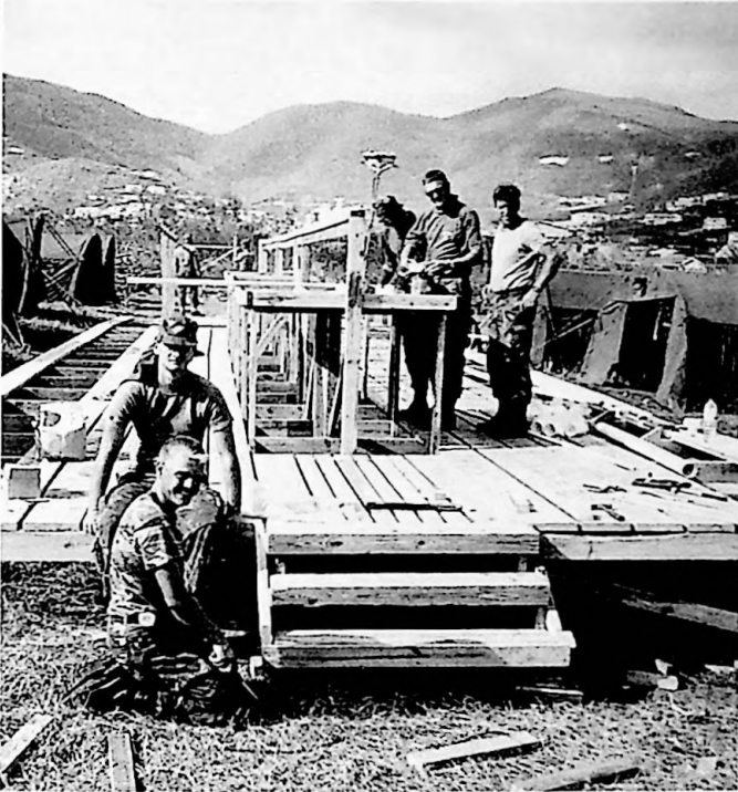
Afb. 6 Het bouwen van een was- plaats in een opvangkamp bestaande uit boogtenten (Foto: E.R. Sinninghe)
